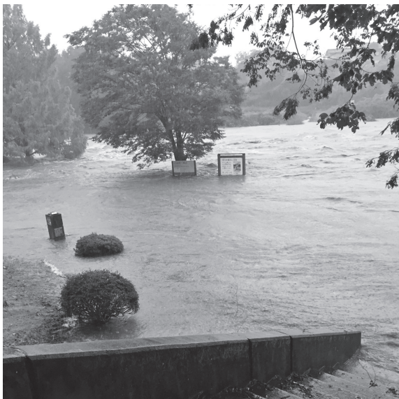
令和元年の台風 19 号により水没する水辺公園（渡瀬地内）
