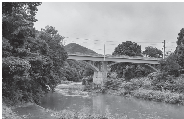
当初の遊歩道計画箇所（渡瀬の水辺公園側から撮影）
