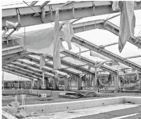
無償譲渡をされた施設です。昭和58年の開設以来、青少年の健全育成や地域住民の健康増進の核となる施設として、町民の皆様にご利用されていましたが、施設の老朽化等により平成20年度より休止しています。平成28年には側面のシートの剥がれた箇所を応急的に補修しましたが、強風や経年劣化により、現在屋根シートが破損している状況です。屋根シートについては、現状のまま放置を続けた場合、強風による飛散の危険性もありますので、早期に撤去したいと考えています。また、プールの解体は早急に進めます。
