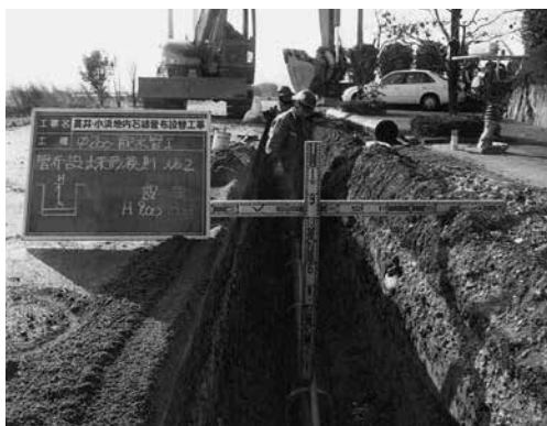
水道管布設替工事
