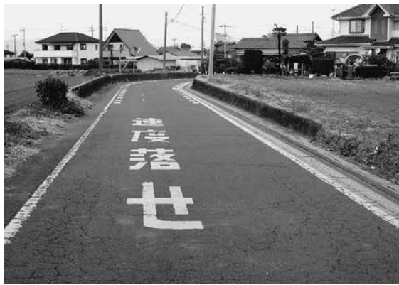
グリーンベルト設置道路（関口地内）
