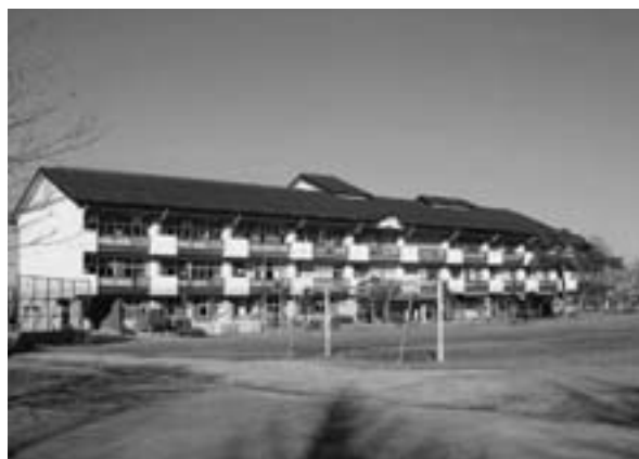
耐震工事が予定される青柳小学校
