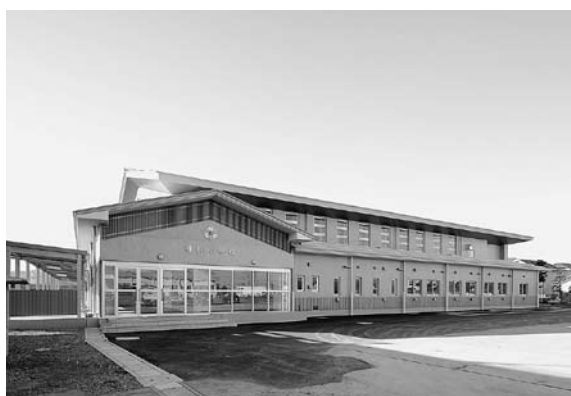
神川中学校体育館（平成24年1月31日完成）
