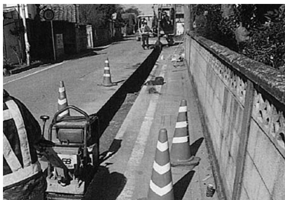
水道石綿管布設替工事（八日市地内）
