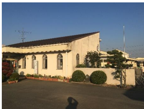
図 10 神川幼稚園外観
