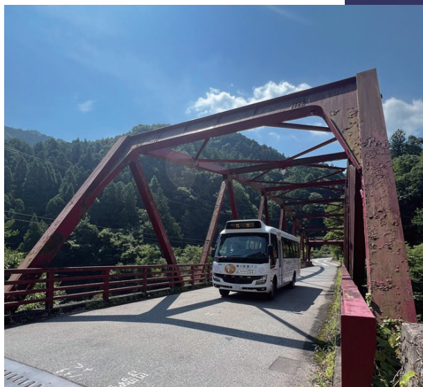
※登仙橋は令和8年3月まで工事を行っています。
