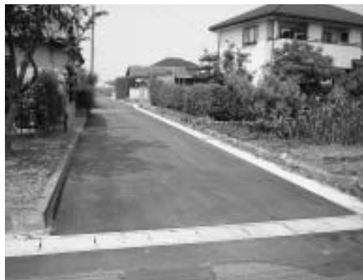
植竹地内の道路改築工事
