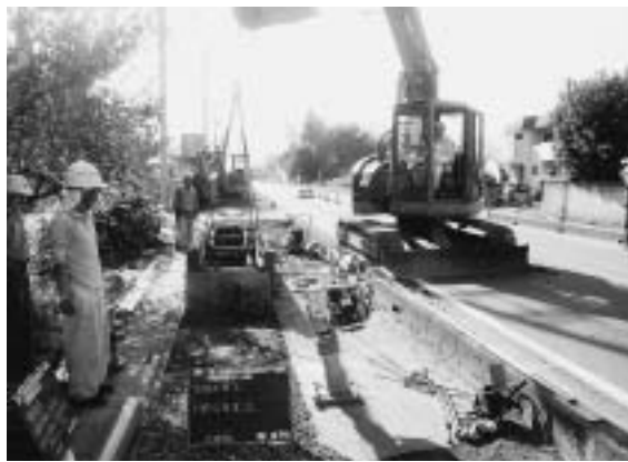
渡瀬地区内下水道工事
