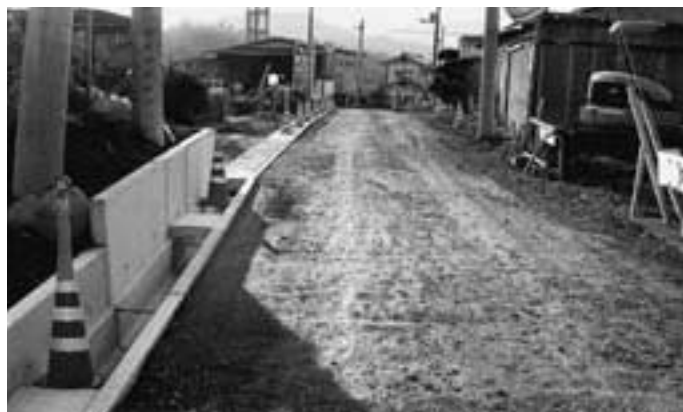
道路改築工事
