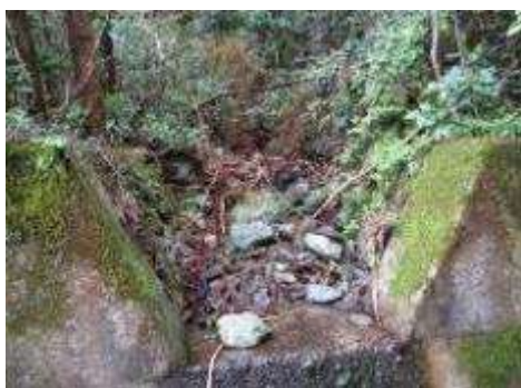
<砂防堰堤の土砂堆積状況>
