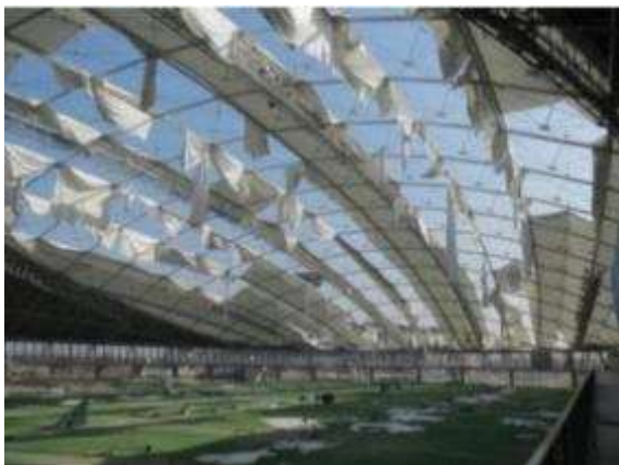
<熊谷市・くまがやドーム（県 HP より）>
