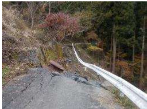
<林道両谷線（路体崩落）>
