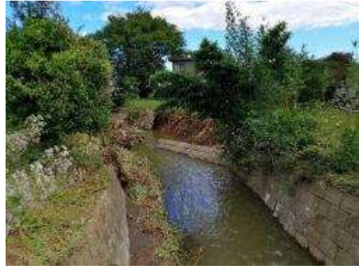
<準用河川金鑽川（護岸崩落）>
