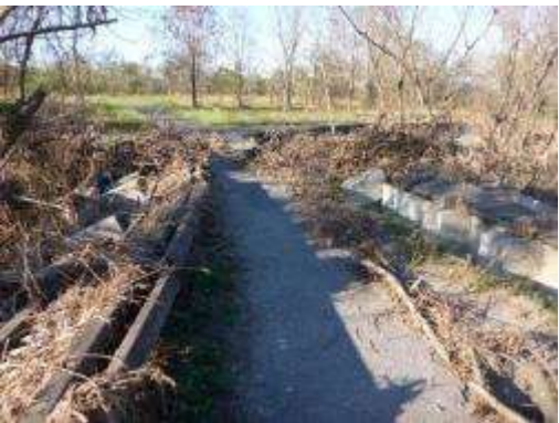
<ゆ〜ゆ〜ランド（遊歩道陥没・高欄損傷）>
