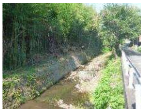
<河川の土砂堆積状況>
