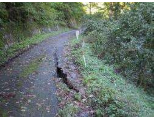
<林道両谷線（路肩崩落）>
