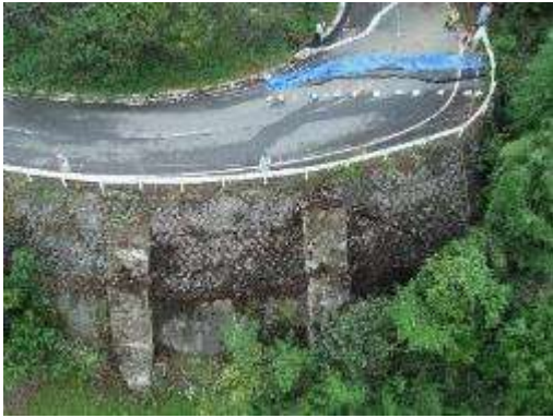
<町道 1-18 号線（擁壁の座屈による路面陥没）>
