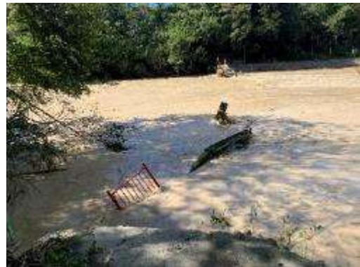
<一級河川神流川（八塩橋の流出）>
