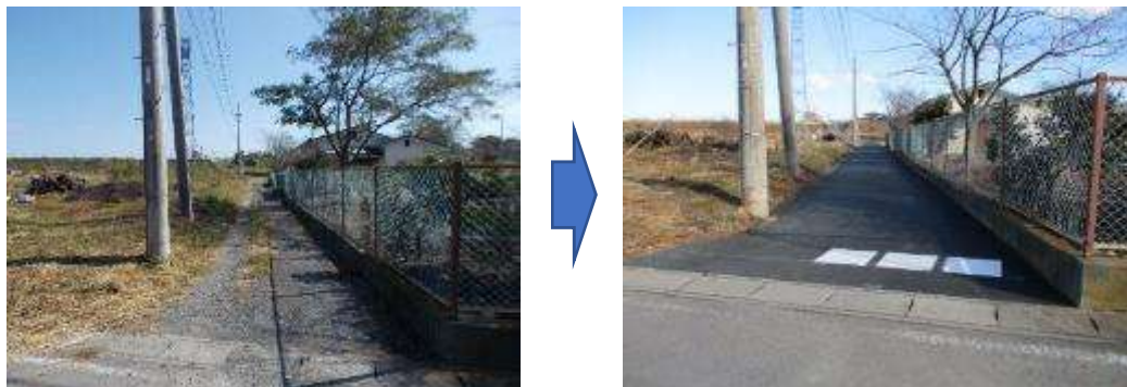
＜町道 4317 号線（令和 2 年度）＞
