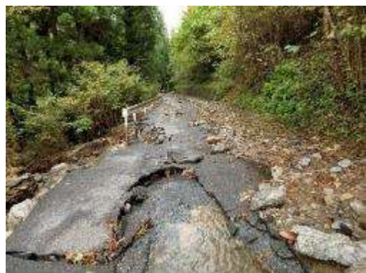
<林道王城線（舗装陥没・路肩崩落）>
