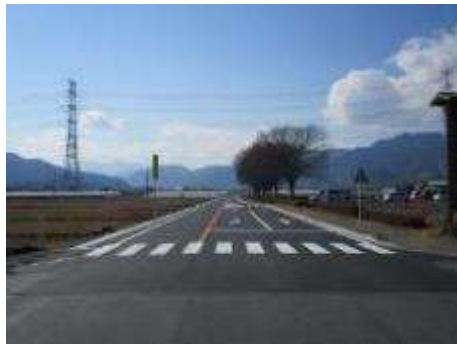
＜町道 5180 号線・令和2年度＞
