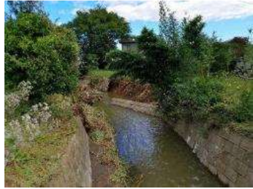
<準用河川金鑽川（護岸崩落）>
