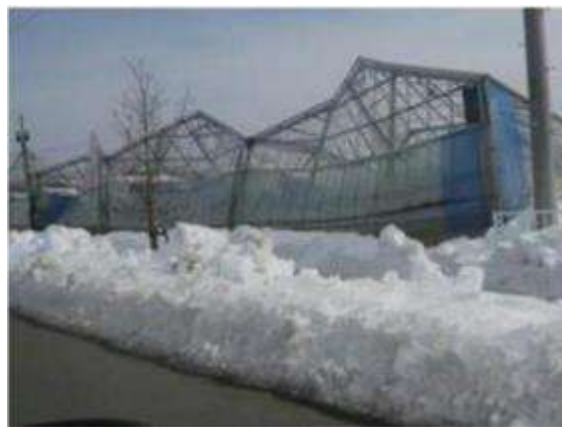
<秩父市・農業用ハウス（県 HP より）>
