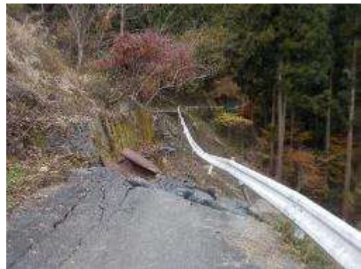
<林道両谷線（路体崩落）>
