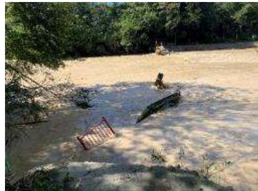
<一級河川神流川（八塩橋の流出）>
