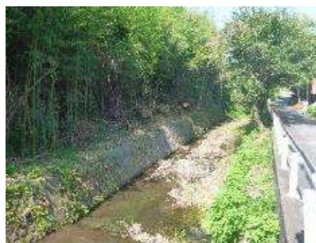
<河川の土砂堆積状況>
