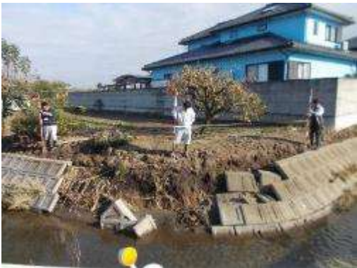
<準用河川金鑽川（張ブロックの流出）>
