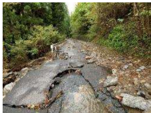
<林道王城線（舗装陥没・路肩崩落）>
