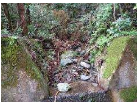
<砂防堰堤の土砂堆積状況>
