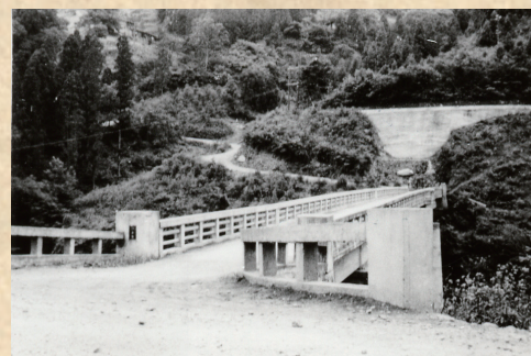
水没した柚木橋
