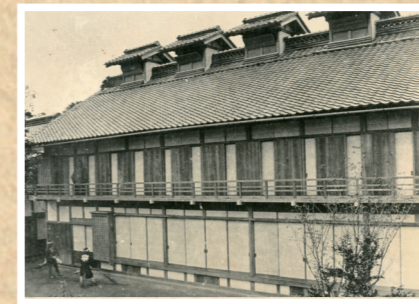
養蚕室 大字小浜地内
