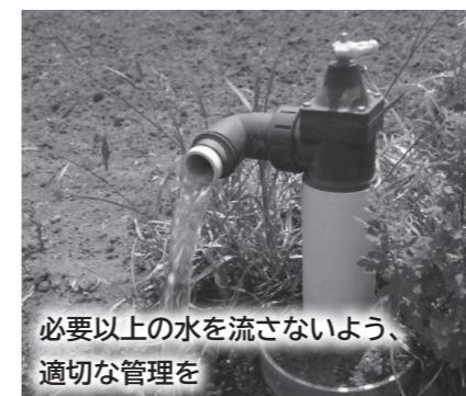
給水栓が破損した様子 水が噴き出します
