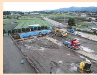
2017年9月 基礎を作るため地盤を掘削
