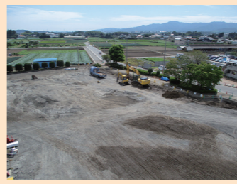
2017年8月 舗装と樹木の撤去
