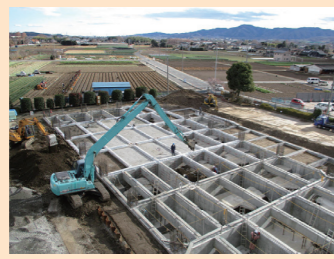
2017年12月 コンクリート流込み
