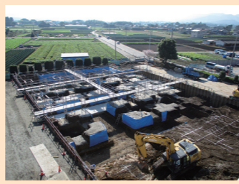
2017年10月 作業通路設置工事 基礎配筋工事
