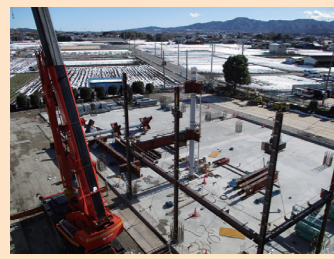
2018年1月 コンクリート打設 鉄骨建方
