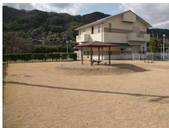
渡瀬下水処理施設
